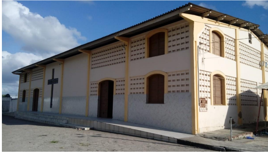
Figura 2: Vista geral da Igreja São Pedro e São Paulo
