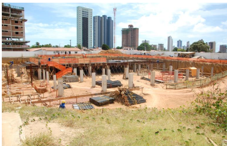
Figura 40- Construção do novo Fórum do TRT 13ª Região
