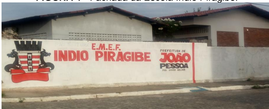
FIGURA 4 - Fachada da Escola Índio Piragibe.
