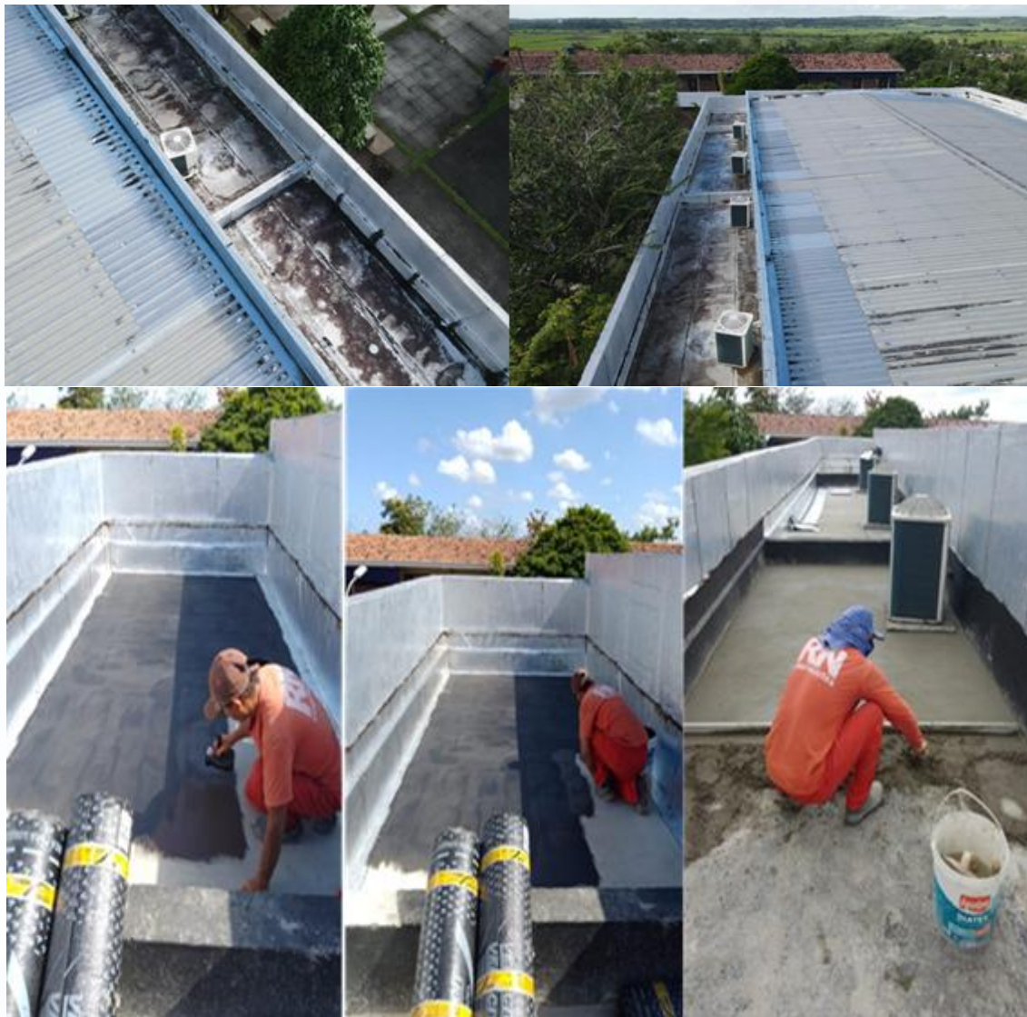
Figura 77 - Obras de impermeabilização da laje técnica do auditório da unidade de Mamanguape, em 2024.
