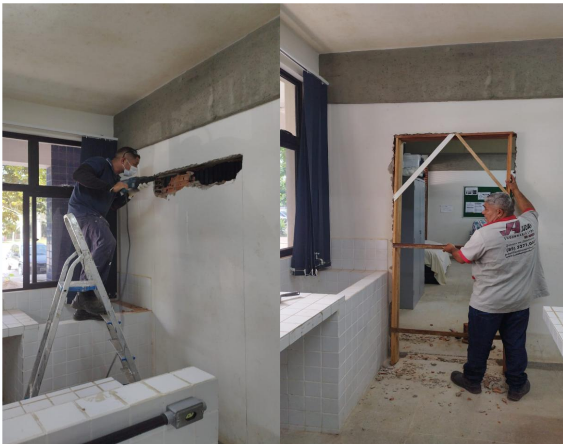
Figura 75 - Instalação de porta na sala RC-105.
