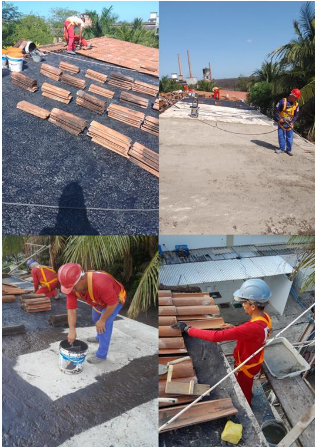
Figura 76 - Obra de instalação das calhas do Bloco A, Central de Aulas de Rio Tinto.
