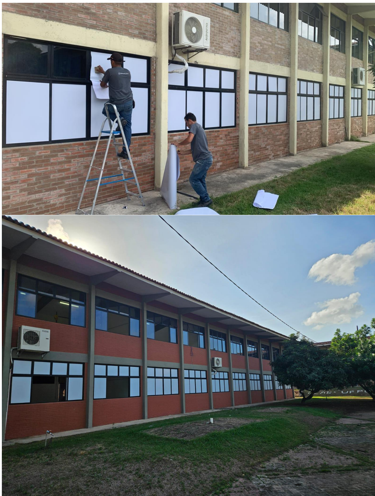
Figura 79 - Revestimento das janelas do Bloco E, na unidade de Rio Tinto, com película black-out.
