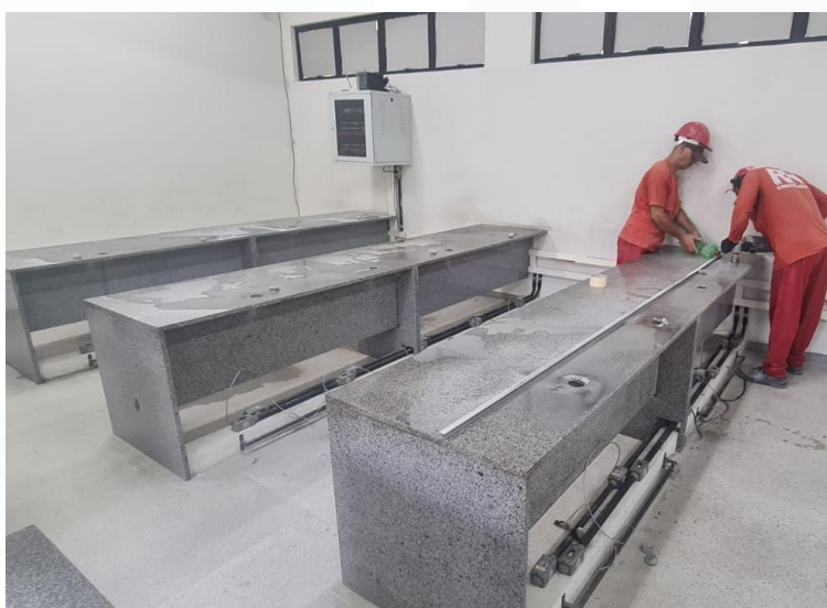
Figura 76 - Obra de perfuração das bancadas e instalações de canaletas nas bancadas dos laboratórios de informática de Rio Tinto.
