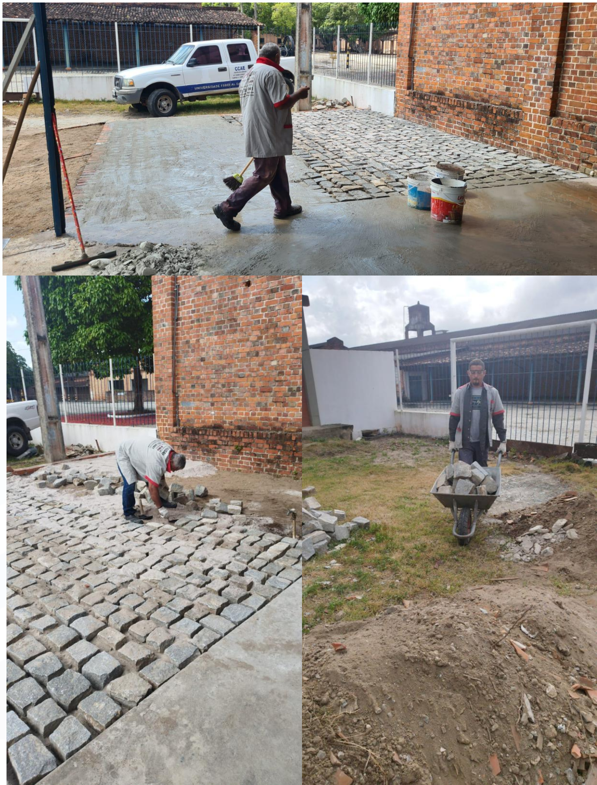
Figura 82 - Construção do piso da garagem dos veículos do Campus IV, na Unidade de Rio Tinto.
