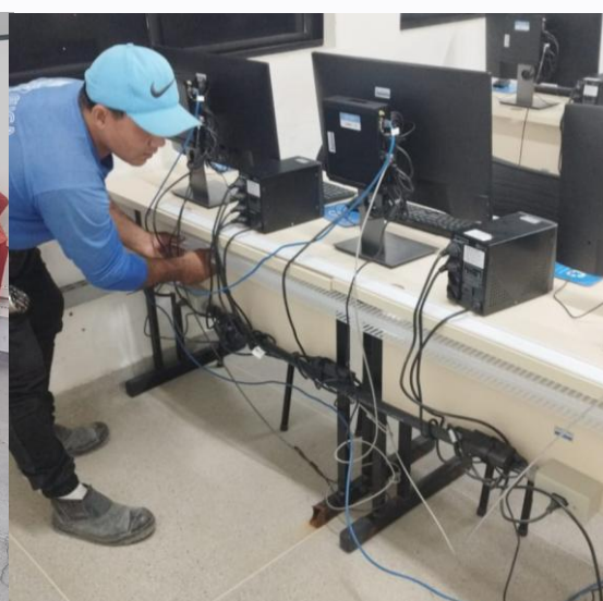
Figura 76 - Obra de perfuração das bancadas e instalações de canaletas nas bancadas dos laboratórios de informática de Rio Tinto.
